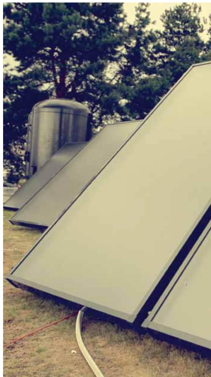
//// //// fot. 17: Ciepła woda pod prysznicem ogrzewana przez kolektory słoneczne.
